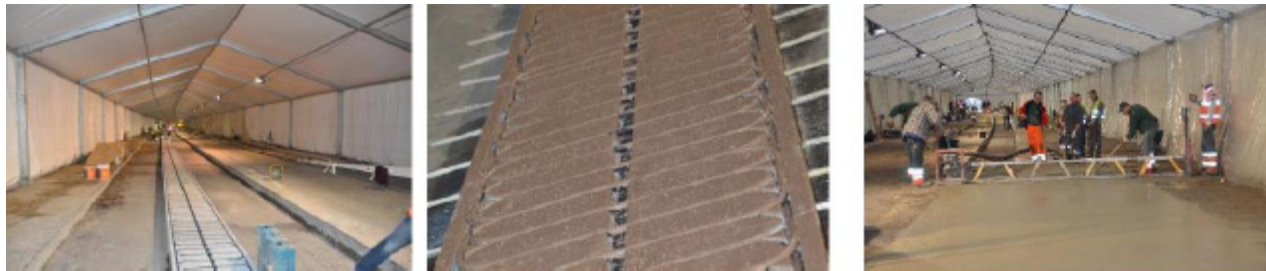
Figura 3. Construcción del tramo de ensayo de hormigón y detalles de los bucles de inducción.
