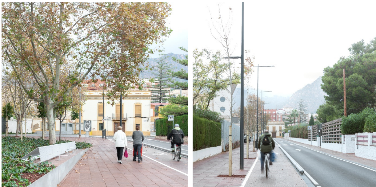
Figura 4. Fotografías del demostrador ejecutado en calle Torre Sant Vicent (Benicàssim).
